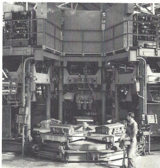
**3** L'atelier d'emboutissage, à partir des bobines de tôle qui arrivent directement des laminoirs, produit les pièces de carrosserie de l'AMI 6. Ces bobines de tôle sont découpées en "flans" qui sont ensuite emboutis sur des lignes de presses de plusieurs milliers de tonnes. L'approvisionnement est automatique.
